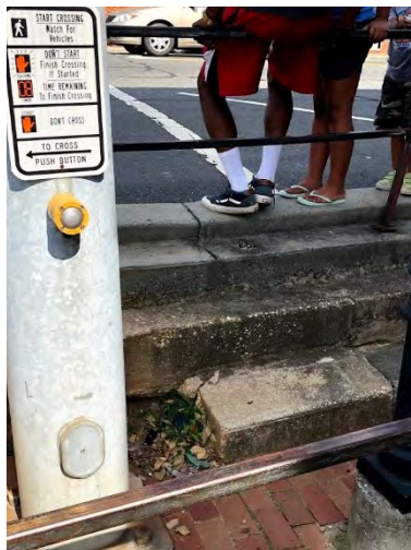
Crosswalk stairs no curb cuts, Route 3 (d)
